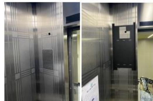
② 브라켓 및 전원부 설치
